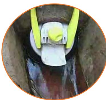
Poignée relevée = Obturateur déverrouillé = Canalisation ouverte
