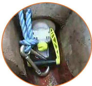
Poignée baissée = Obturateur verrouillé = Canalisation fermée
