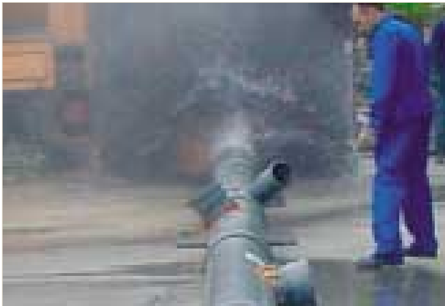
Montage de l'essai hydrocurage
