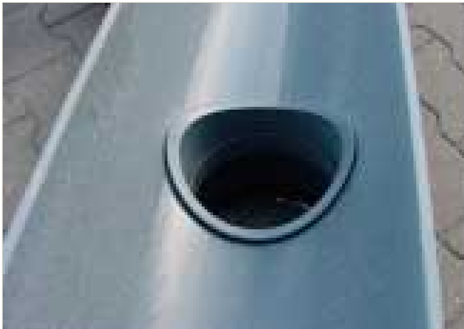
Vue intérieure après hydrocurage
