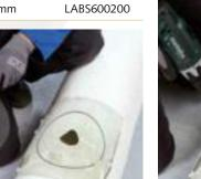
Dans les cas d'un orifice pré-percé par un robot dans la gaine, le gabarit de perçage- Liner est utilisé. Son utilisation est obligatoire afin de réaliser un perçage correct et dans le respect des côtes de perçage nécessaires au montage du branchement-Liner Système CONNEX. Pour connaître les étapes de pose nécessaires, consultez les instructions de pose du fabricant.
