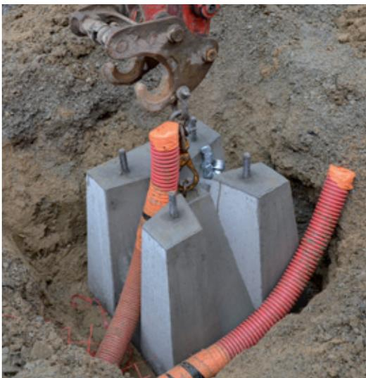
Destiné à maintenir le mât d'éclairage, servant donc de stabilisateur, le massif est posé en fond de fouille, sur un lit de sable et compacté avec un remblai de bonne qualité.
